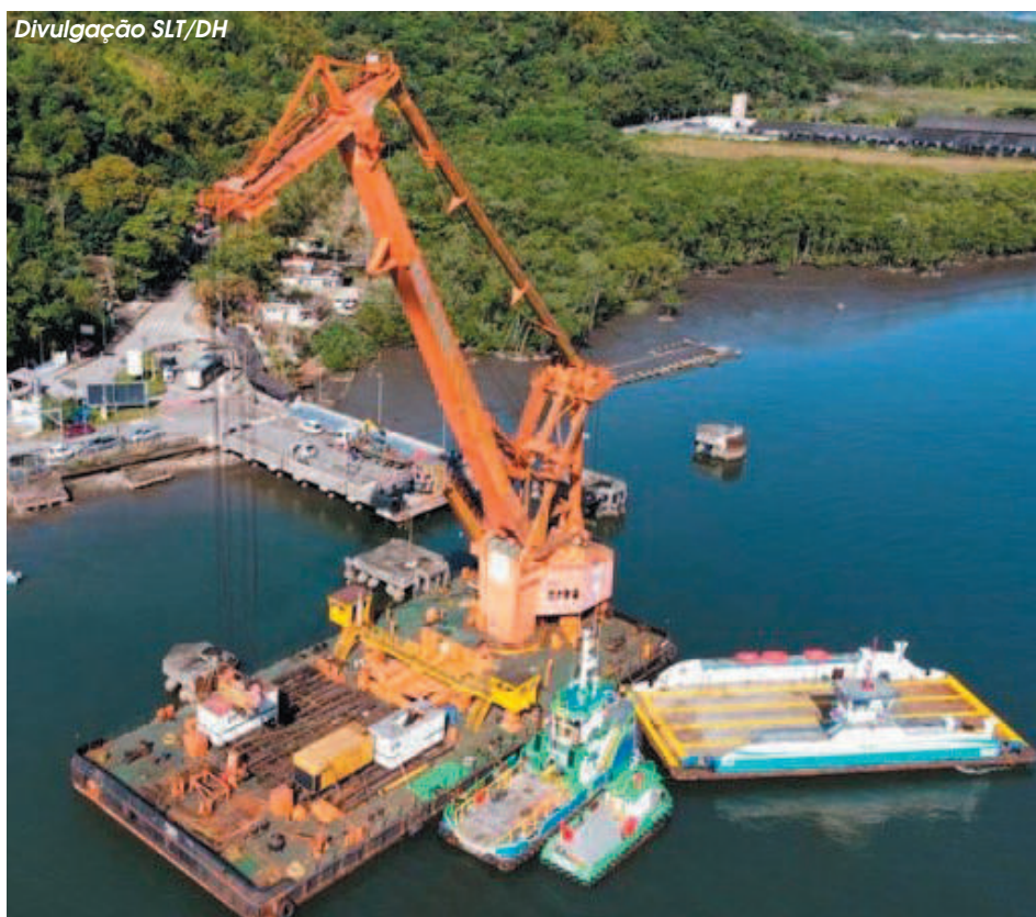
Guindaste de mais de 300 toneladas içou nesta quinta-feira (14) estrutura que submergiu com a força da maré
