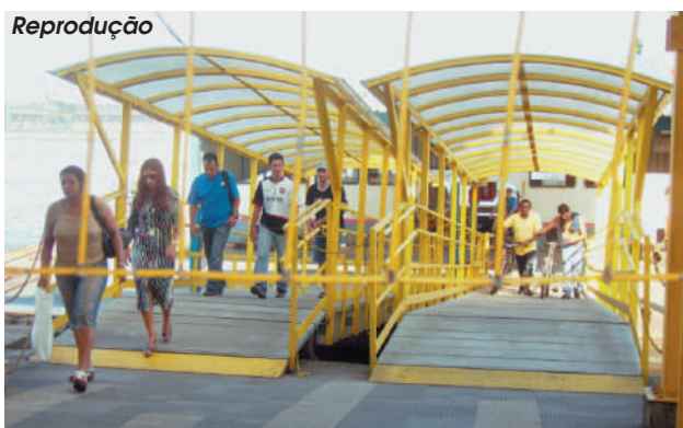
Valor inclui obras no Guarujá e em Santos, para melhorar acessibilidade e implantar um sistema de combate a incêndios
