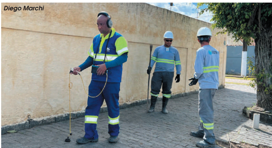
Sabesp realizou o anúncio durante uma vistoria técnica que demonstrou o uso do geofonamento para detectar vazamento invisível
