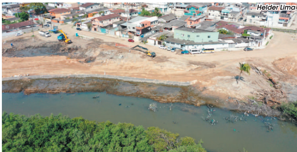
Dos três piscinões que estão sendo construídos para a obra de macrodrenagem, dois já entraram em nova fase de obras
