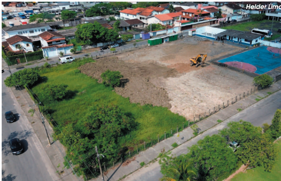
Área construída será de 1.443,45 metros quadrados e está localizada na atual sede da GCM, no Jardim Helena
